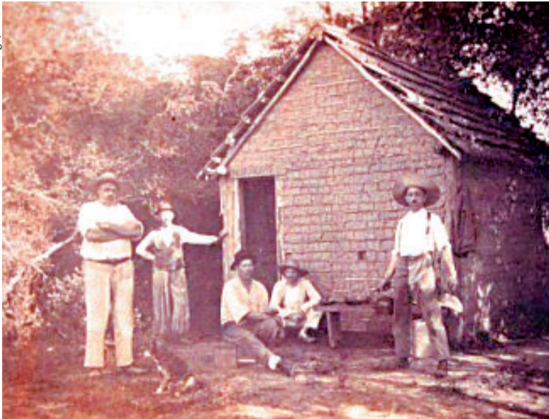
Os próprios imigrantes cortavam as pedras e as madeiras para construir suas casas
