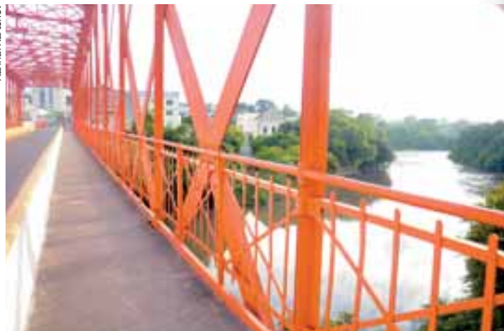
A Ponte Dr. Diniz Assis Henning, popular Ponte Metálica, uma das vias de ligação
