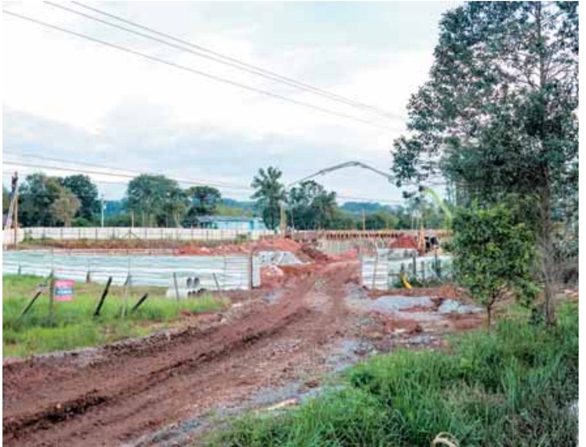
Construção do prédio começou em dezembro, em um lote com 8,2 mil metros quadrados. Obra deve ficar pronta até o fim do ano
