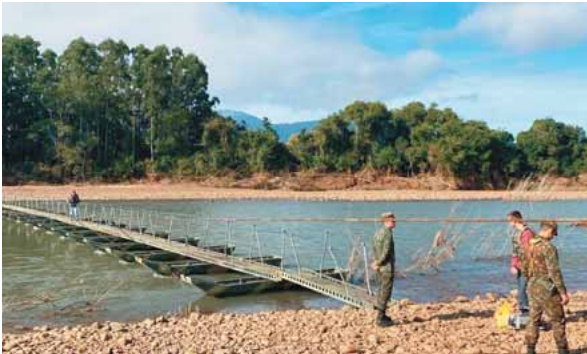
Estrutura passou a ser nova opção para a travessia de pedestres no Rio Pardo. Essa é a segunda passarela instalada no município
