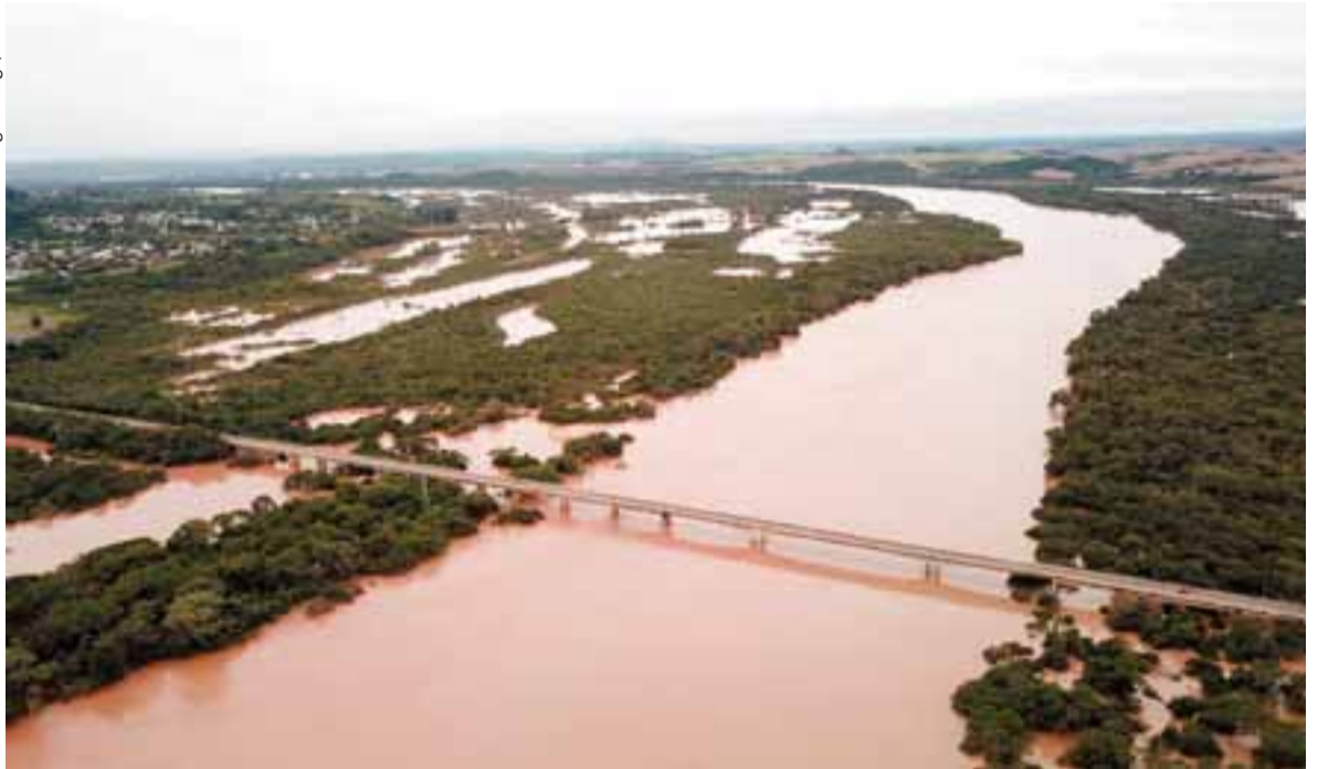
Ponte sobre o Rio Jacuí em Rio Pardo segue sendo monitorada e pode ter o trânsito interrompido se o rio continuar subindo
