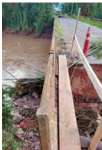
Travessia apenas para pedestres na ponte para Linha Antão
