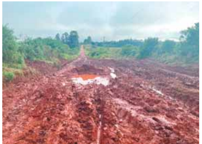
Elevações nas estradas, os chamados “borrachudos”, são um desafio para as equipes
