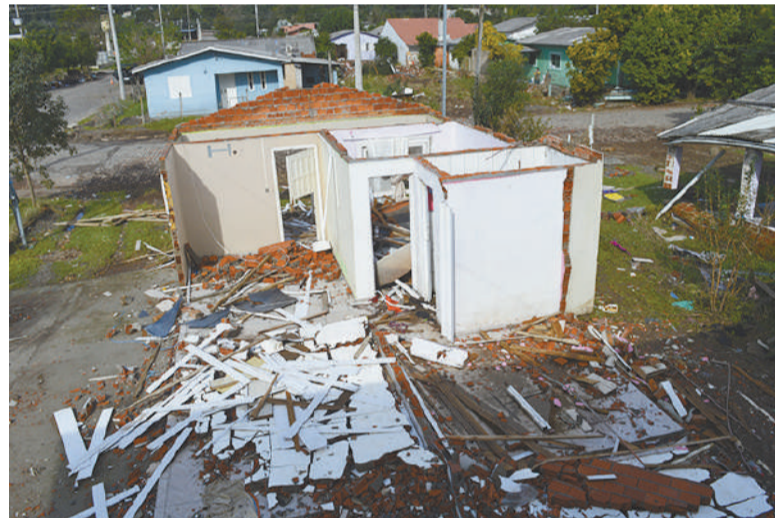
Da casa da mãe de Carine, quase nada restou, nem mesmo a estrutura
