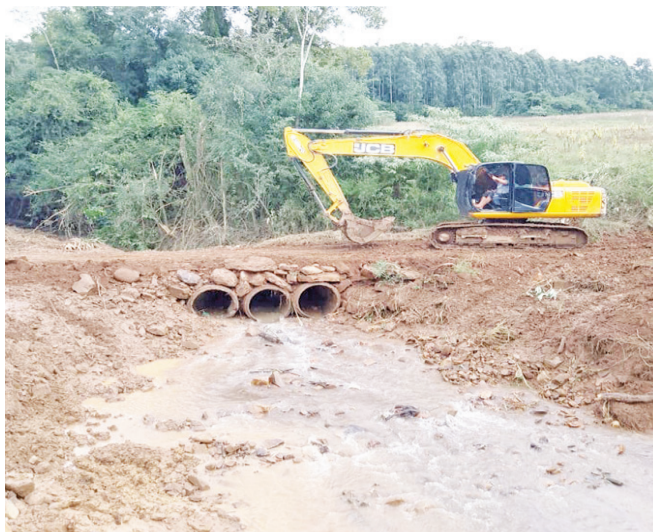
Reparos em Taboãozinho fundos
