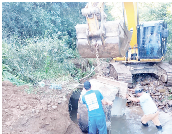
Reparos em Taboãozinho fundos
