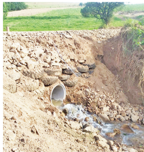
Bueiro em Linha Taquaral, em frente a propriedade de João Hass
