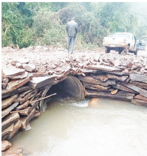
Reparos em Taboãozinho fundos
