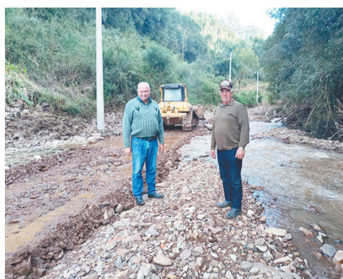
Recuperação da estrada em Baixo Pilão
