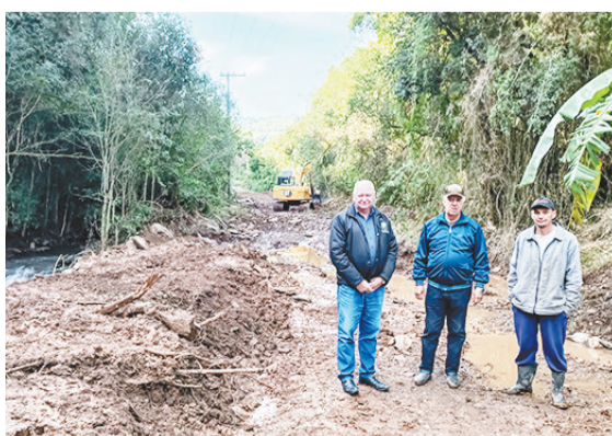
Recuperação de estrada em Linha Central
