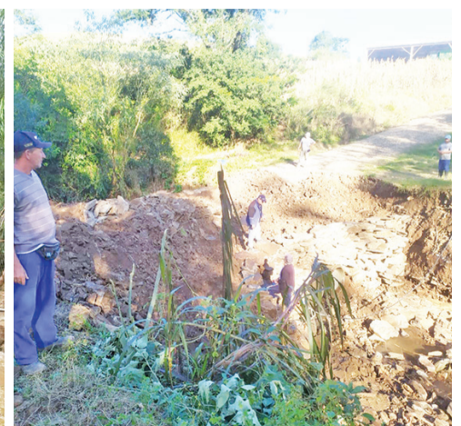
Bueiro em Linha Santa Cruz após intervenção da equipe das Obras
