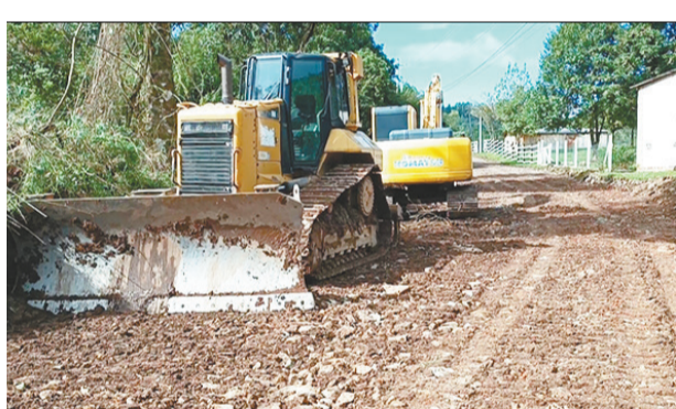
Recuperação da estrada em Linha Apolinário
