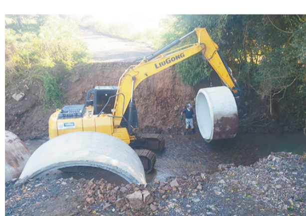
Colocação de canos da ponte Arroio Bonito para Linha Turvo
