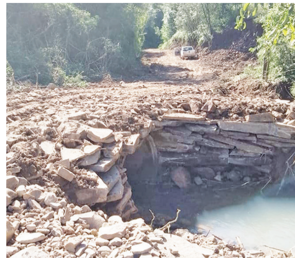
Reparos em Taboãozinho fundos
