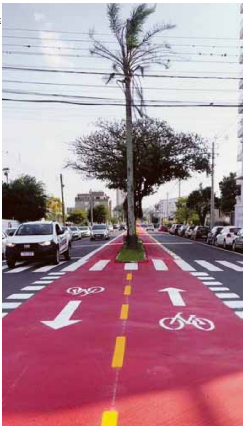
Com o asfaltamento concluído, trecho recebeu sinalização e a pintura das ciclofaixas
