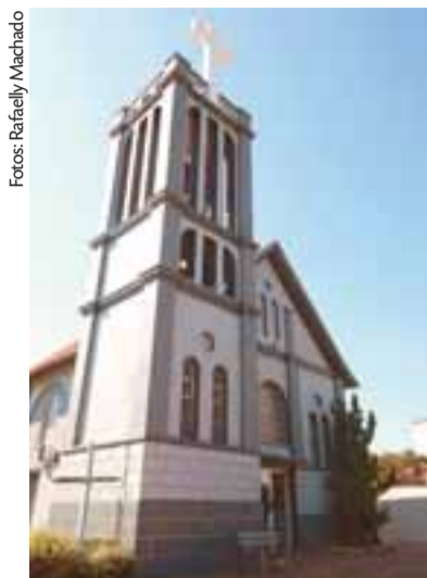
Pintura renovou fachada da construção
